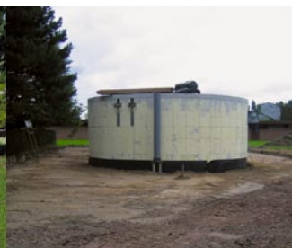
pas gegoten vergistingstank
