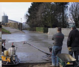
omgevingswerken: gieten van betonverharding
