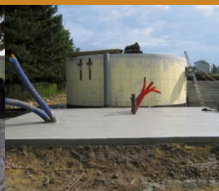
grondwerken: vloerplaat voor WKK, pomphuis en opslagtanks
