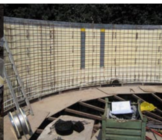
plaatsen netwapening, wandverwarmingselementen en wanddoorvoeren
