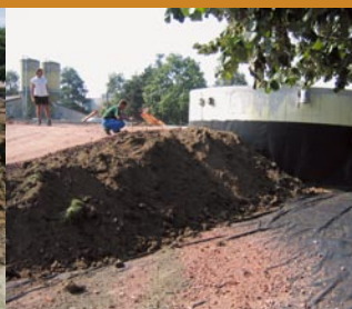
grondwerken: aanleg van aanrijhelling voor doseervijzel
