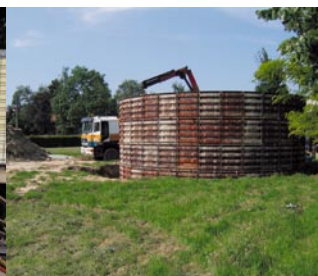
vergistingstank klaar om beton te storten
