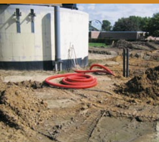
grondwerken: plaatsen van de ondergrondse piping
