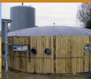
druktest biogasopvang na montage van dekzeil
