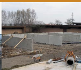
omgevingswerken: plaatsen sleufsilos voor opslag biomassa
